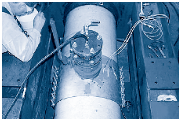
Abbildung 8-2 Druckprüfung der Schellen- und Ventilbaugruppe
