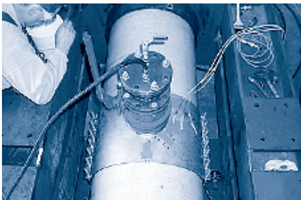
Bild 10-12 Druckprüfung für Anbohrschelle und Ventilbaugruppe
